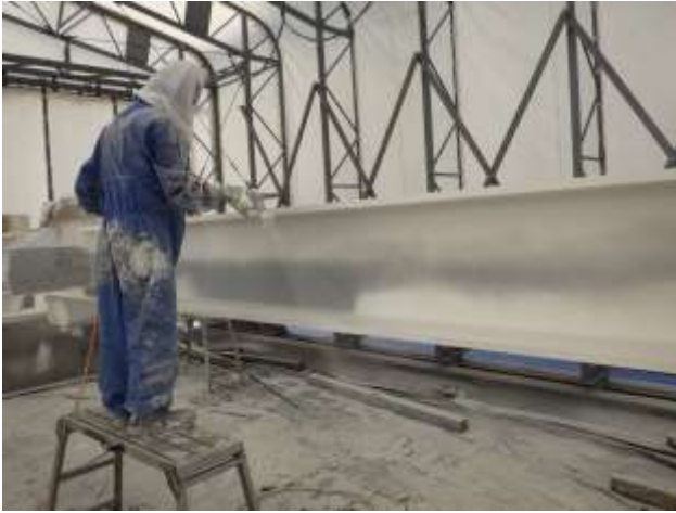
工場内 上塗り塗装の様子
