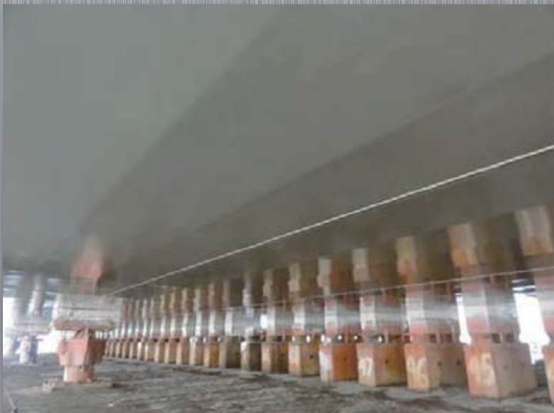
平滑性AC/BC塗装後の状態（盤木が反射してみえる）
