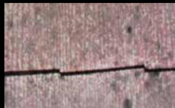
全体に塗膜の剥がれが見られ、下地表面層は脆く、吸込みが大きい状態。
