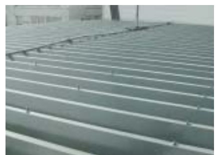
写真2 屋根表面 (素材：金属折半)
