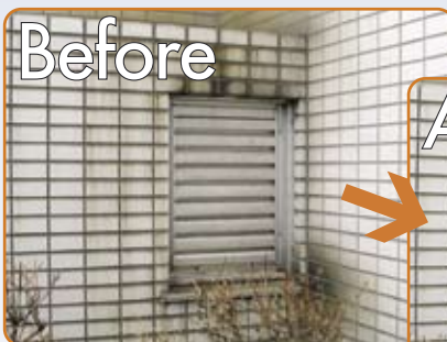
外壁タイルの汚れの洗浄
