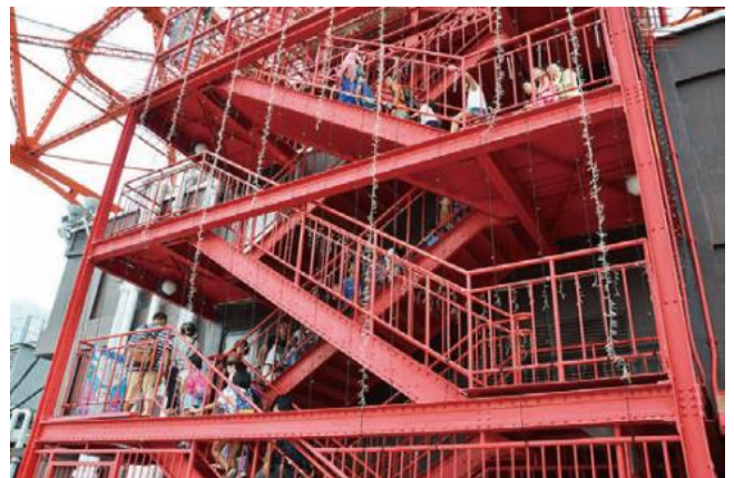
○東京タワー外階段の様子
